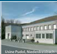
Usine Pudol, Niederdreisbach
