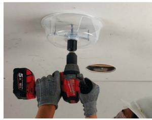
Idéale pour forer de larges diamètres pour les tubes de l'installation de climatisation, les canaux de ventilation, les spots de plafond et les haut-parleurs.
